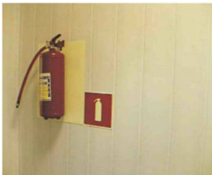
Рисунок А.6 - Обозначение фотолуминесцентной 50-мм лентой контура пожарного оборудования и использование знаков пожарной безопасности
