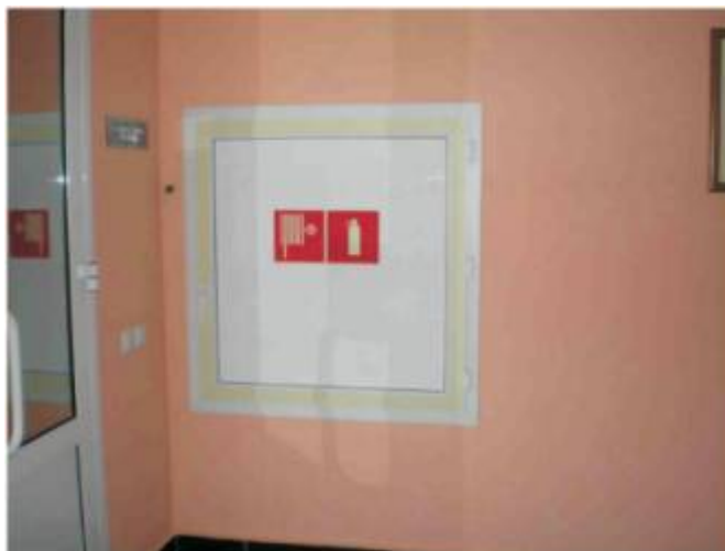
Рисунок А.6 - Обозначение фотолуминесцентной 50-мм лентой контура пожарного оборудования и использование знаков пожарной безопасности
